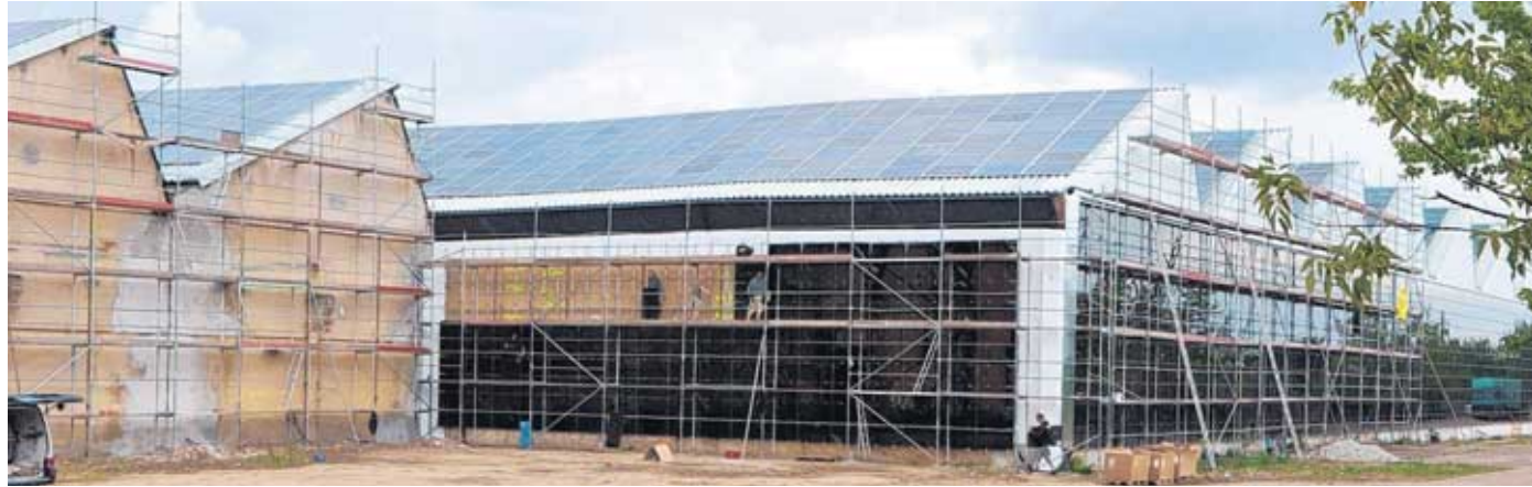
Letzte Arbeiten an den Ziehwerk-Hallen in Döbernitz: Nicht nur auf dem sogenannten Sägezahn Dach, sondern auch an den Fassaden sind Solarmodule angebracht. Foto: Manfred Lüttich
